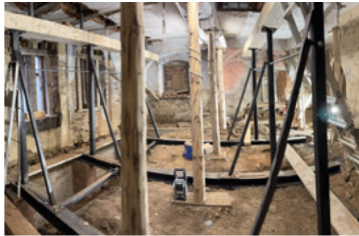
Ausbau der Wickeldecke und Einbau einer Stahlbetondecke im 1. OG zur dauerhaft statischen Verankerung der historischen Fassade und Nutzung als Kammermusiksaal
