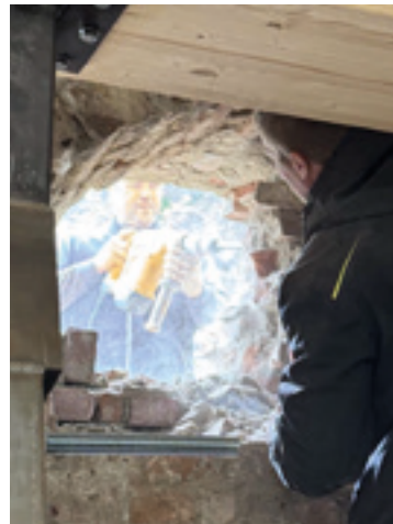
Wiederherstellung der ursprünglichen Fensteröffnungen mit Korbbögen und neuer Gewände
