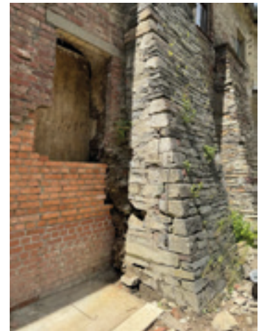
Abbruch des westlichen Pfeilers und Öffnung des dahinterliegenden Fensters
