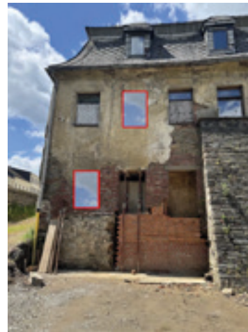
Wiederherstellung der ursprünglichen Fensteröffnungen mit Korbbögen und neuer Gewände
