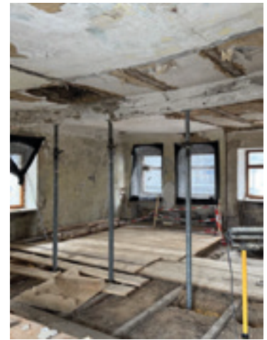
Ausbau der Wickeldecke und Einbau einer Stahlbetondecke im 1. OG zur dauerhaft statischen Verankerung der historischen Fassade und Nutzung als Kammermusiksaal
