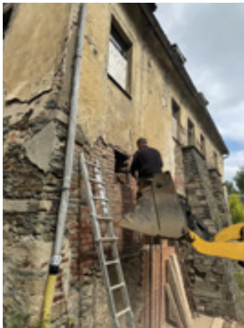
Sanierung der Hofwand
