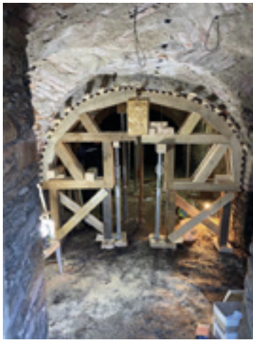
Sanierung des Kreuzgewölbes im Keller
